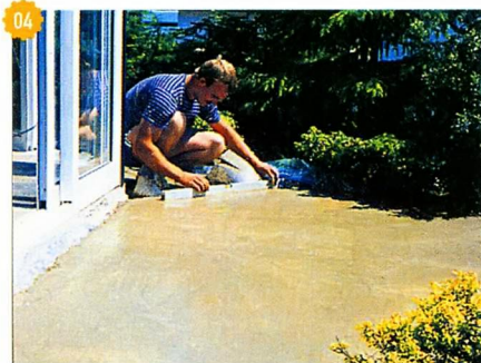
↑ После укладки арматурной сетки заливают второй слой основания. Бетон уплотняют, а когда он слегка схватится, выравнивают бруском-правилом.
