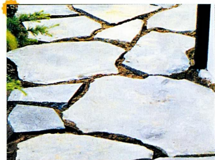
↑ При укладке плит следят за тем, чтобы раствор был равномерно распределён, плиты не выступали одна над другой, а швы между ними были одинаковыми.
