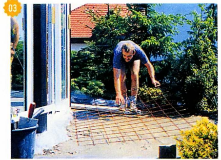
↑ Сначала укладывают слой бетона до половины толщины основания и раскладывают по нему арматурную сетку. Отдельные куски сетки кладут с напуском друг на друга.
