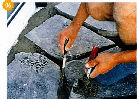
↑ Широкие пробелы между плитами заполняют каменной крошкой, а затем — раствором.
