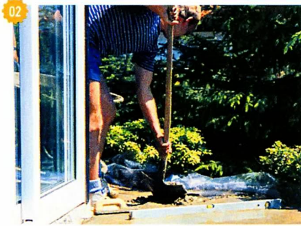
↑ При заливке основания бетон выкладывают на дренаж равномерным слоем. Общая толщина основания — около 10 см. Заливают его в два приёма.
